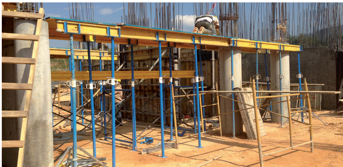
Encofrado de viga in-situ y losas prefabricadas
