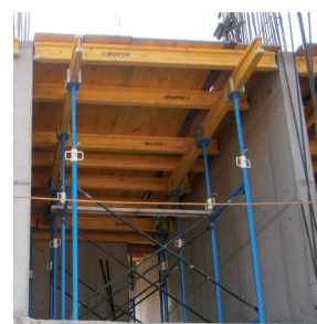
Situación de encofrado
