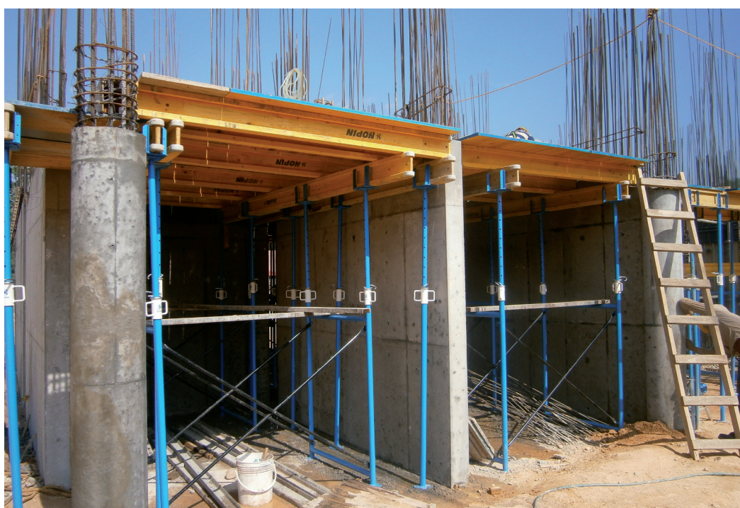
Encofrado de losas con muros de carga
